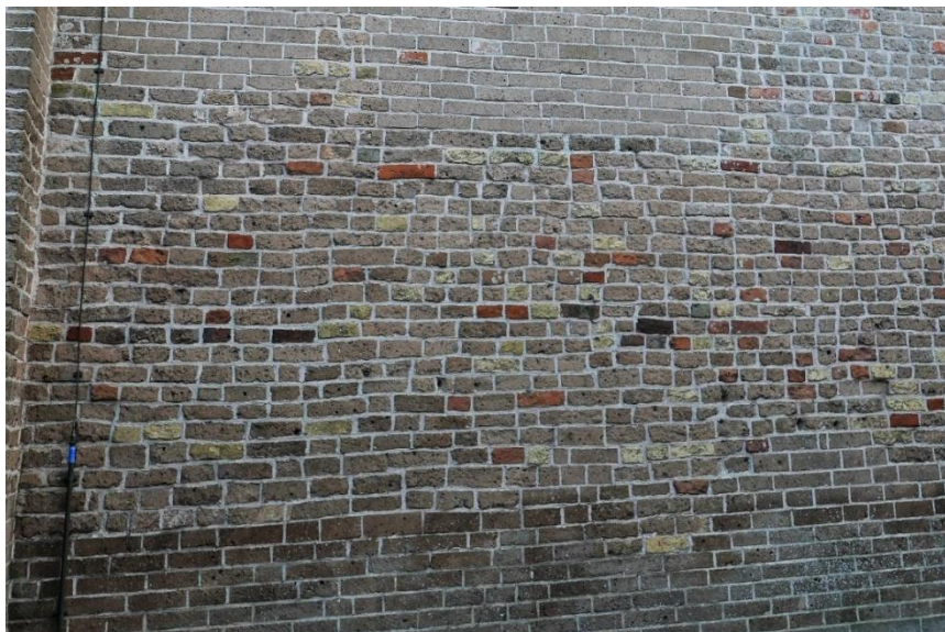
174. Rode en gele baksteen tussen de tufsteen in de noordgevel.
