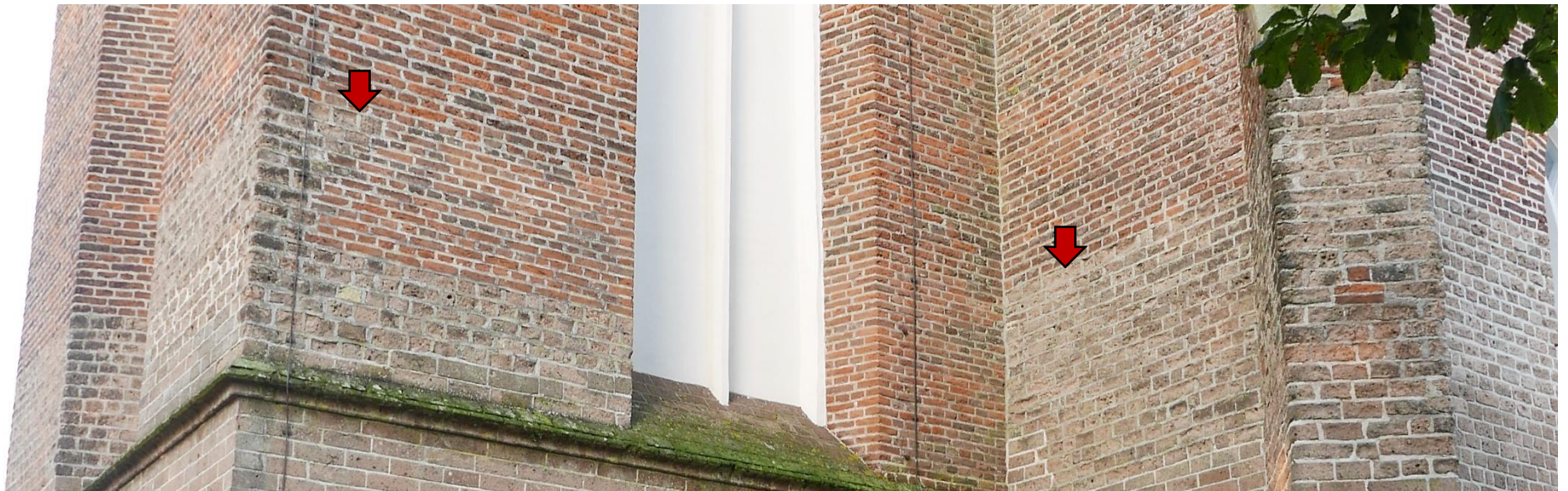
82. De lijn is onderbroken, de tufsteen heeft deels plaatsgemaakt voor baksteen...
