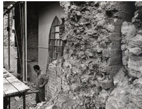
63- 66. Op de noordoosthoek werd een bouwnaad van één steen breed tussen het restant van het koor (de muurdam) en de hoek van het schip beter zichtbaar gemaakt. De naad lijkt er in eerste instantie op te wijzen dat het koor eerder werd gebouwd dan het schip, aangezien de muur van de laatste koud tegen die van het koor aan staat. Toch hoeft dit niet per sé het geval te zijn. De grote breedte van de naad (een steenlengte) kan er op wijzen dat de oostgevel van het schip werd afgekapt om ruimte te maken voor de bouw van het koor. Toen het koor af was, werd de kier weer opgevuld. In dat geval zou de muur van het schip juist ouder zijn. De restauratiefoto's laten zien dat er veel meer origineel materiaal werd vervangen dan nodig. Met het eeuwenoude kistwerk werd nonchalant omgesprongen.
