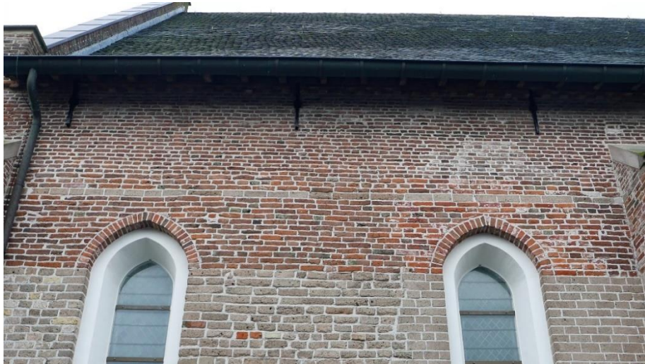
175. Strekkenlaag van tufsteen in de bakstenen ophoging, noordgevel.
