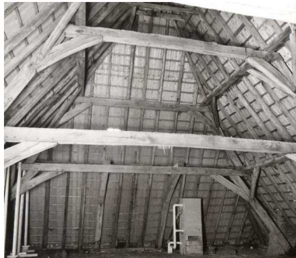
91 - 96. Voor de iets verlaagde kap van 1836 was gebruik gemaakt van de middeleeuwse schargebinten. Omdat de dakhelling flauwer moest worden, werden de stijlen in de pengaten van de korbels gezet en de korbels werden iets verderop opnieuw gepend. Op de foto rechtsonder is het (beschadigde) oude pengat nog zichtbaar.
