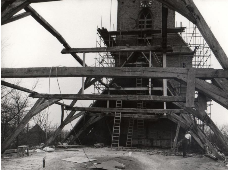
97 - 101. Sloop van het oude dak en opbouw van het nieuwe.
