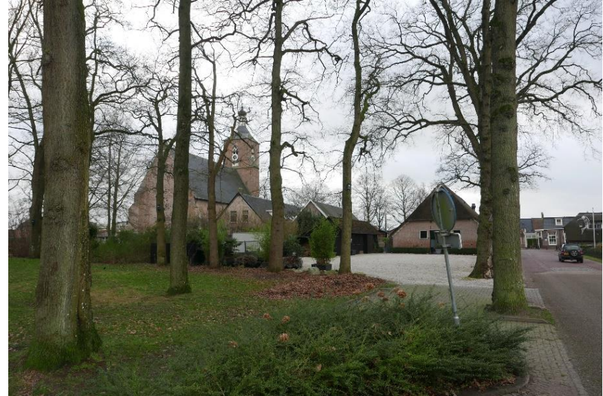
234. Zicht op de kerk vanaf de Kloosterstraat.
