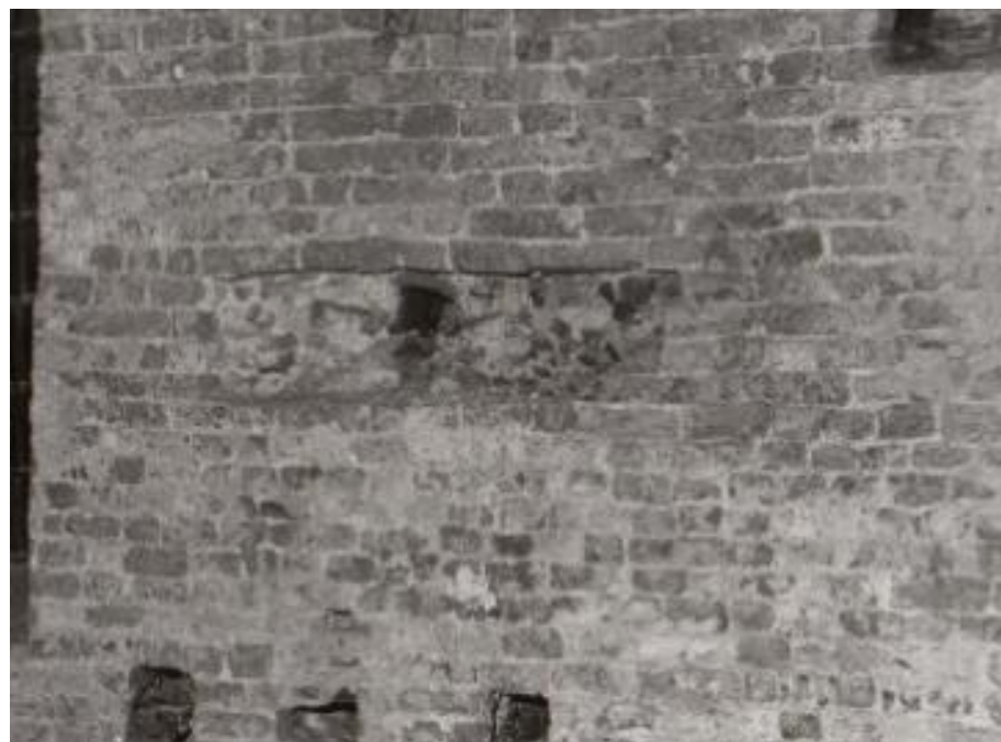
173. Kistwerk achter de tufstenen noordmuur (binnenzijde).
