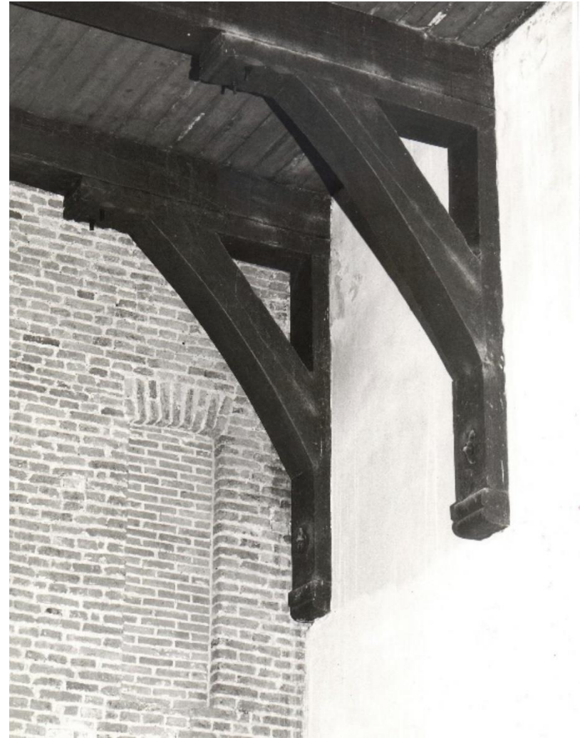
87. De muurstijlen uit 1927 voor de restauratie.
