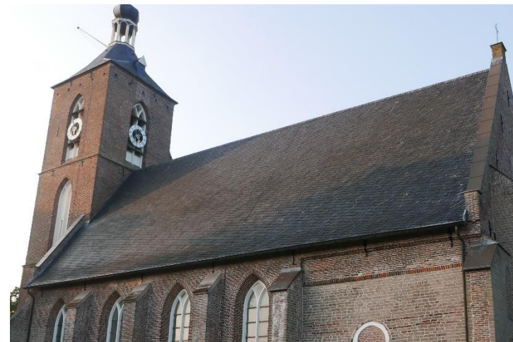
103. Op het westelijke gedeelte waren stormlatten bevestigd in verband met valwinden bij de toren. Een aftekening op de toren laat zien dat het dak uit 1836 een flauwere dakhelling had dan de middeleeuwse voorganger (pijl).
