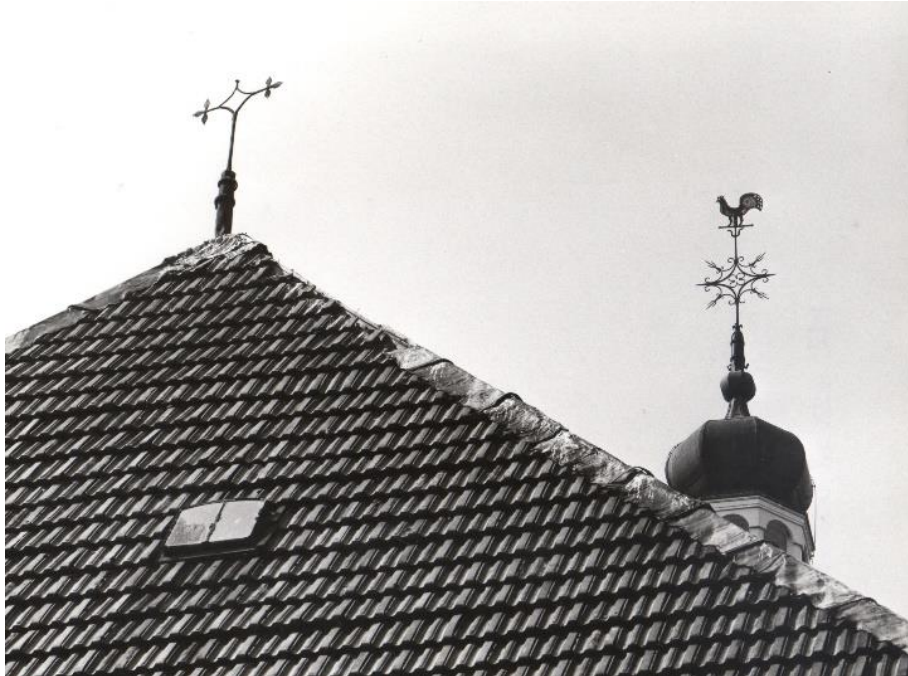
102. Het kerkdak uit 1836 had voor de restauratie aan de oostzijde het karakter van een schilddak. Het was gedekt met gesmoorde, gegolfde Friese dakpannen.
