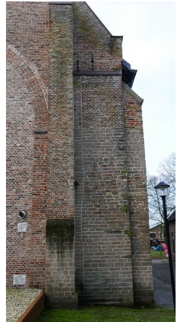
63- 66. Op de noordoosthoek werd een bouwnaad van één steen breed tussen het restant van het koor (de muurdam) en de hoek van het schip beter zichtbaar gemaakt. De naad lijkt er in eerste instantie op te wijzen dat het koor eerder werd gebouwd dan het schip, aangezien de muur van de laatste koud tegen die van het koor aan staat. Toch hoeft dit niet per sé het geval te zijn. De grote breedte van de naad (een steenlengte) kan er op wijzen dat de oostgevel van het schip werd afgekapt om ruimte te maken voor de bouw van het koor. Toen het koor af was, werd de kier weer opgevuld. In dat geval zou de muur van het schip juist ouder zijn. De restauratiefoto's laten zien dat er veel meer origineel materiaal werd vervangen dan nodig. Met het eeuwenoude kistwerk werd nonchalant omgesprongen.
