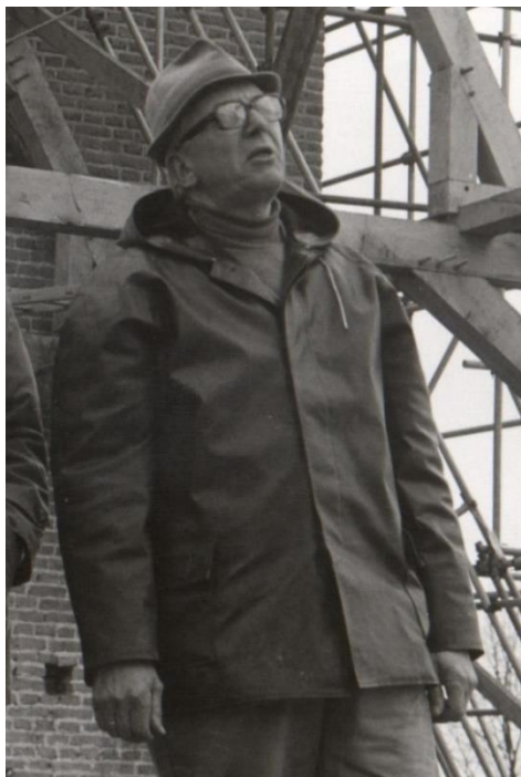
32. Corneille F. Janssen bekijkt de vorderingen aan het nieuwe dak.
