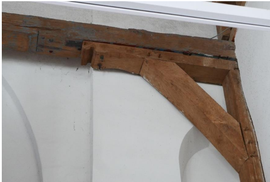
88. De enige trekbalk van voor 1927. Muurstijl, korbeel en sleutelstuk dateren uit de zeventiger jaren.
