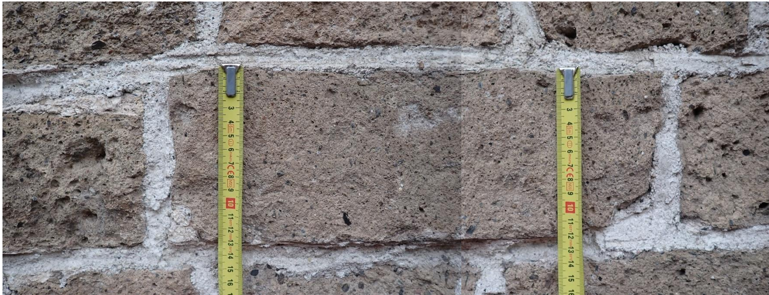
170. Veel blokken tufsteen zijn aan één kant dunner, zoals dit blok dat links 13 cm en rechts 12 cm meet. cm.
