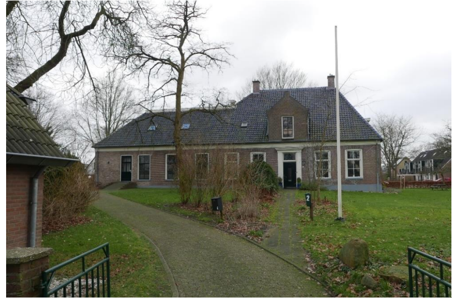
161. De pastorie met in het linker gedeelte De Bron (met de kelders) en rechts een woning.
