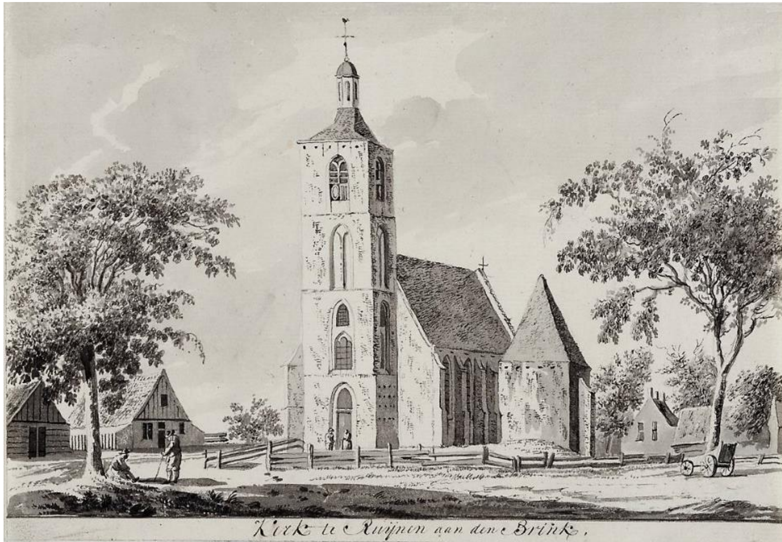
19. De prent van H. Tavenier uit 1786 is de meest getrouwe historische tekening van de kerk. De Catharinakapel met zijn piramidedak en blinde gevels heeft een zeer atypisch voorkomen. Op de achtergrond de sinds lang verdwenen kloosterhoeve, die gezien de kloostervensters een flinke ouderdom moet hebben. Opmerkelijk is dat het gotische koor, dat de dezelfde hoogte als het schip zou hebben gehad en ook in perspectief dus zichtbaar zou moeten zijn, niet wordt weergegeven. De raamvensters in het schip zijn al hun vorktracering kwijt. De torenvoet is aan de rechterzijde voorzien van vier rijen kortelinggaten. Ook onder de dakranden van het koor, de kapel en de toren (waar ze tot op heden bewaard zijn gebleven) zijn deze steigergaten aangegeven.
