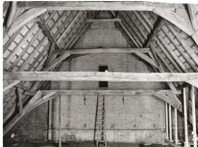
91 - 96. Voor de iets verlaagde kap van 1836 was gebruik gemaakt van de middeleeuwse schargebinten. Omdat de dakhelling flauwer moest worden, werden de stijlen in de pengaten van de korbels gezet en de korbels werden iets verderop opnieuw gepend. Op de foto rechtsonder is het (beschadigde) oude pengat nog zichtbaar.
