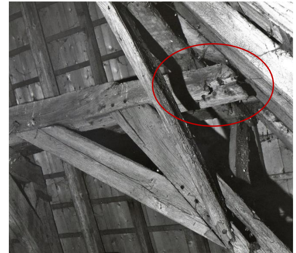
91 - 96. Voor de iets verlaagde kap van 1836 was gebruik gemaakt van de middeleeuwse schargebinten. Omdat de dakhelling flauwer moest worden, werden de stijlen in de pengaten van de korbels gezet en de korbels werden iets verderop opnieuw gepend. Op de foto rechtsonder is het (beschadigde) oude pengat nog zichtbaar.
